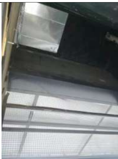
图 5 项目臭气排放口照片
