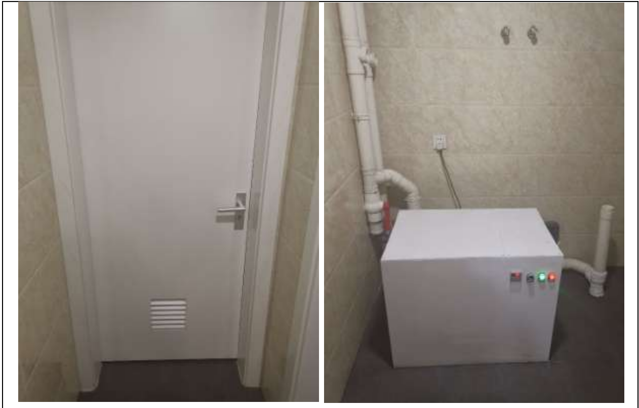
图 7 污水处理设施照片
